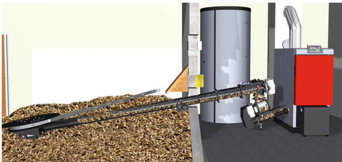
Abb. 42: Eine automatisch beschickte Hackschnitzel- heizung mit Federkern-Raum- austragung und Schnecke zum Transport des Brennmaterials
