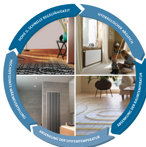
Abb. 25: Einflussfaktoren für effiziente Wärmeübergabe
