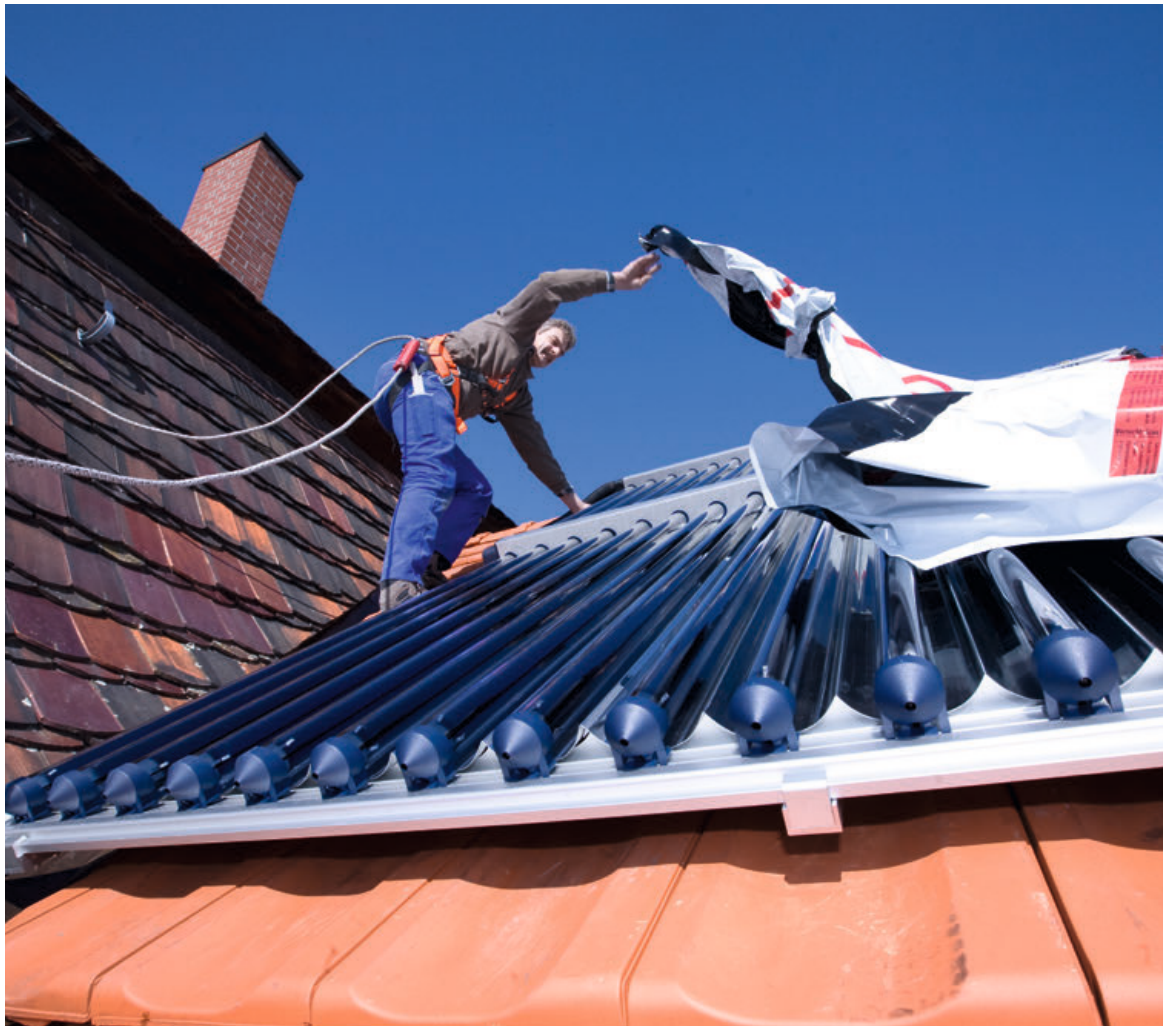
Abb. 53: Anlagenbeispiel – Vakuumröhren- kollektor
