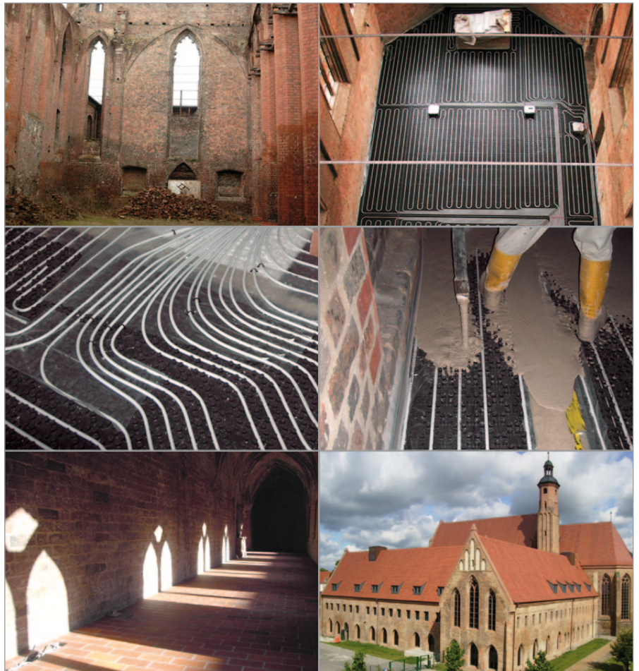
Neuaufbau und Nutzung des Pauliklosters Brandenburg als Museum, Einbau eines Flächenheizsystems in Nass- und Trockenbauweise
